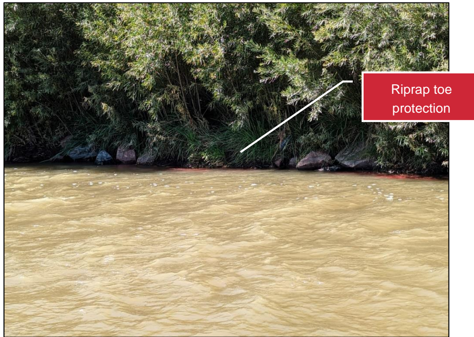
Figure 5. Longitudinal riprap toe.
